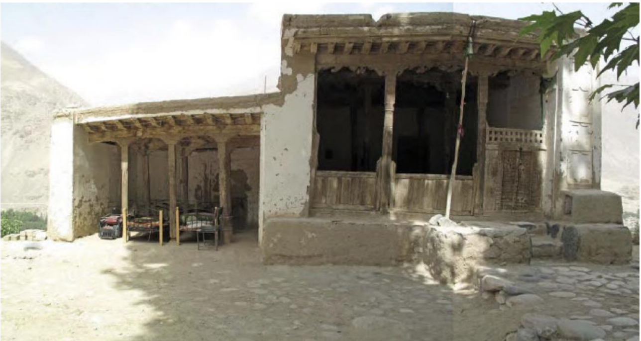
Figura 6: il mausoleo prima delle operazioni di restauro del 2013.
