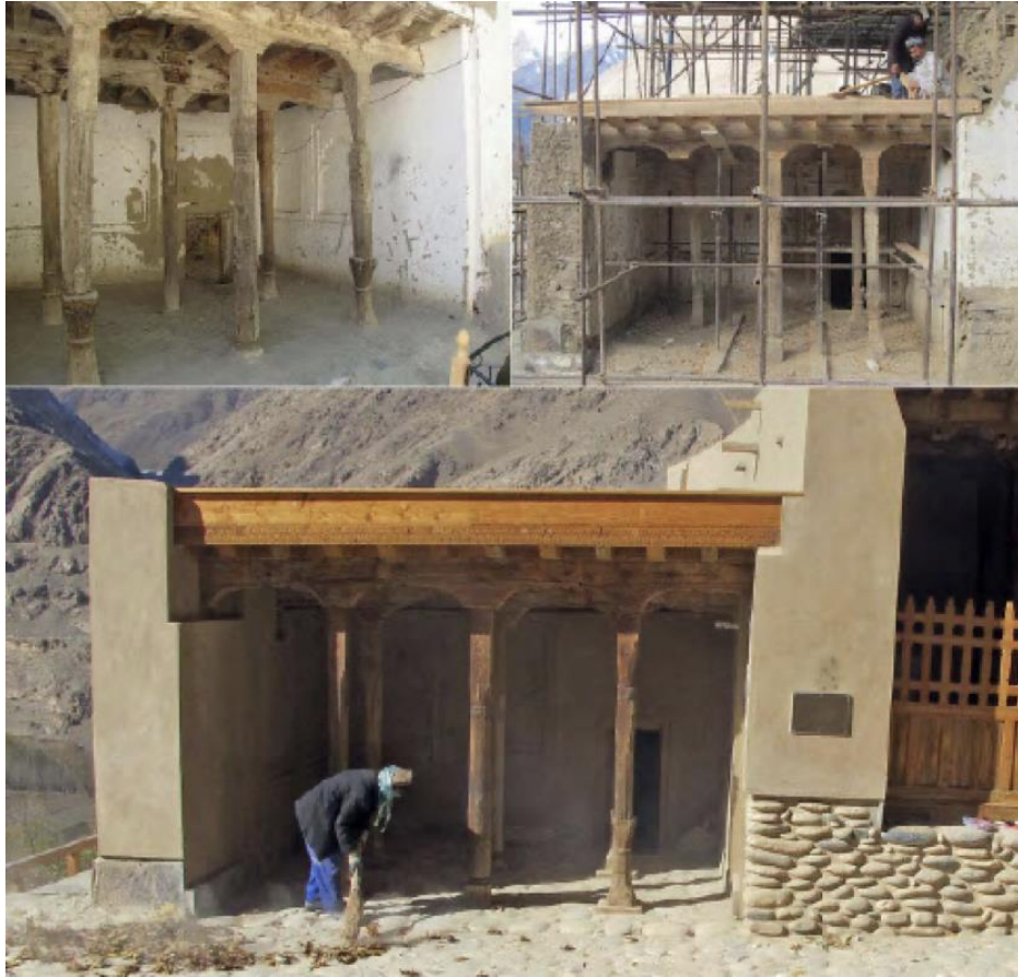
Figura 3: la veranda-portico inferiore prima, durante e dopo il restauro.
