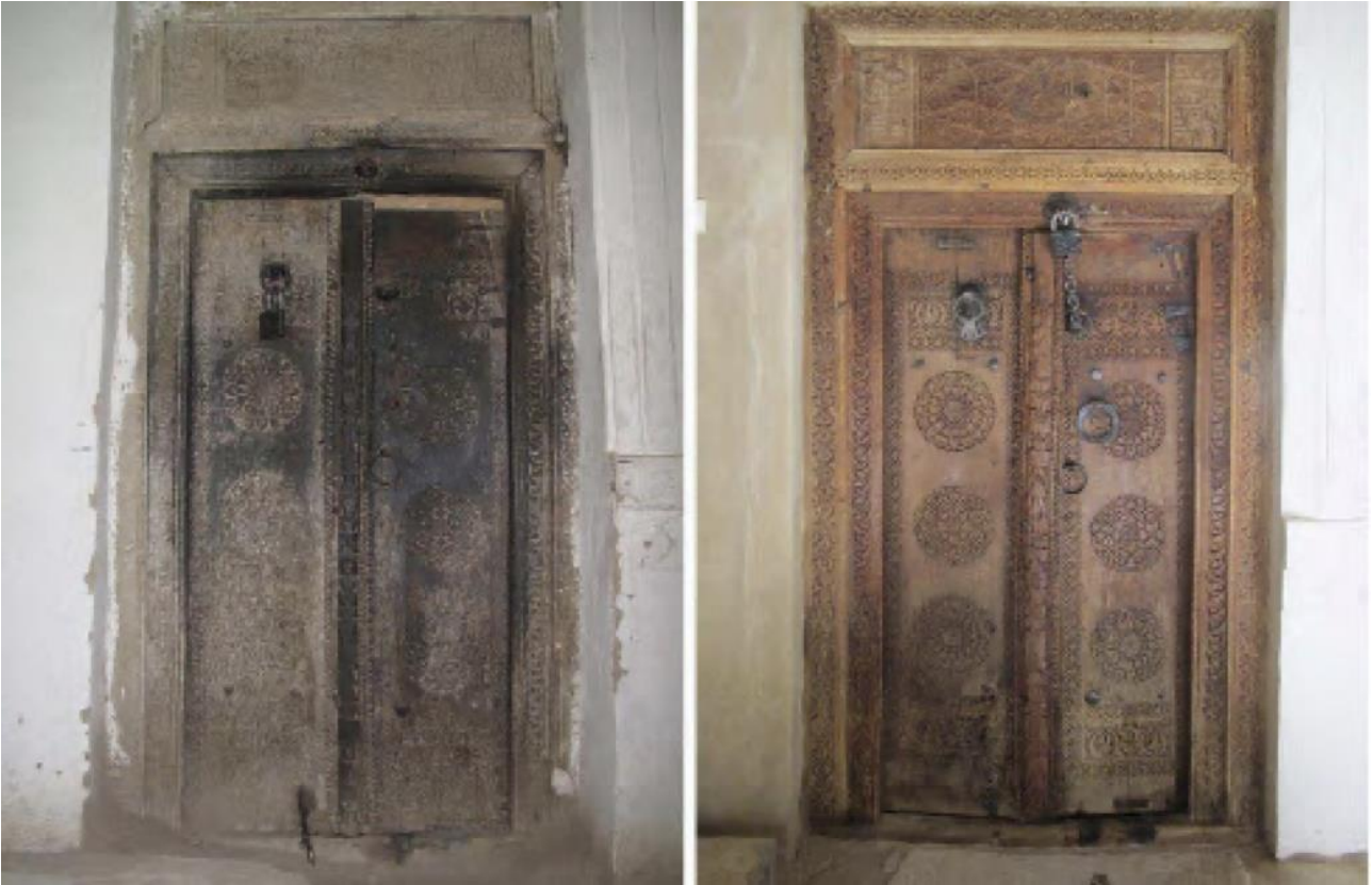
Figura 5: la porta d'ingresso a due ante del mazār prima e dopo il restauro.
